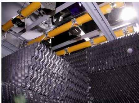
k) Por el sólido colector principal de tubo de acero, galvanizado en baño después de la fabricación.
